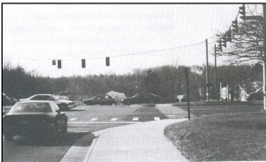
Figura 37 – Sistema de sustentação de semáforos por cabos
