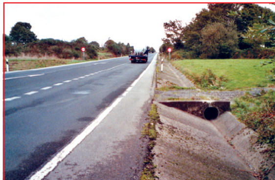
Veículos desgovernados podem ser dirigidos à barreira vertical da estrutura de drenagem
