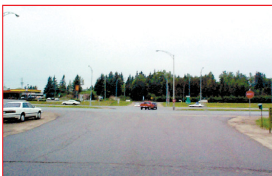
Largura excessiva leva a velocidades altas
