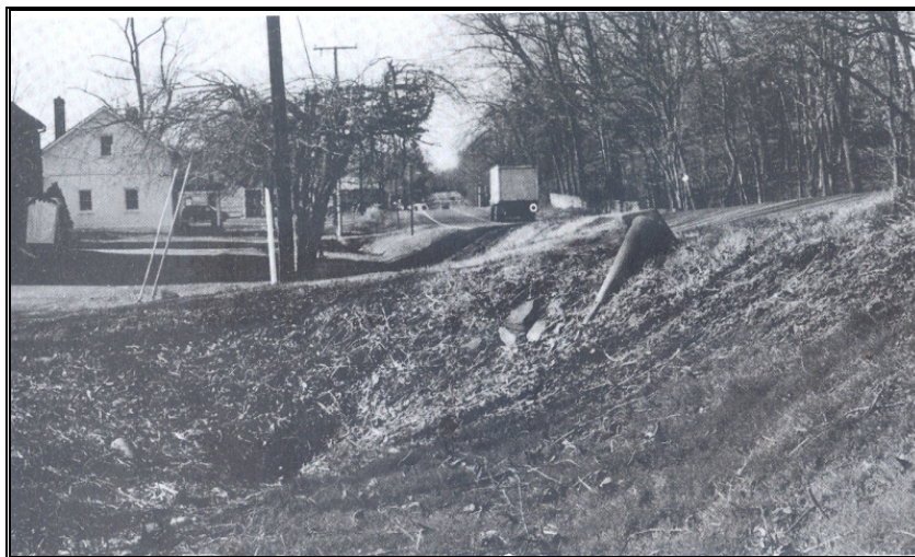
Figura 22 – Taludes laterais elevados
