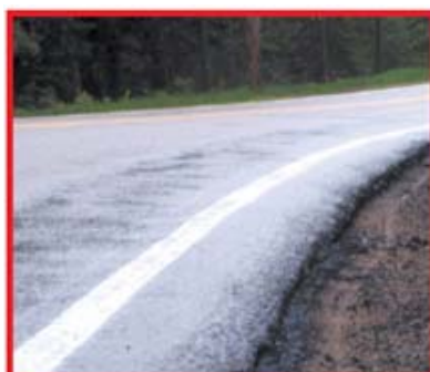
Figura A.15 – Acostamento em desnível
