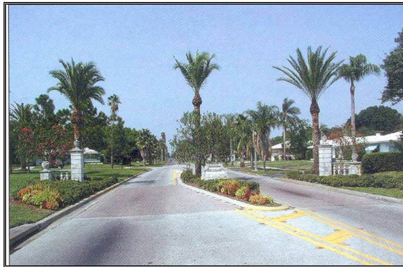
Figura 43 – Acesso de conjunto residencial
