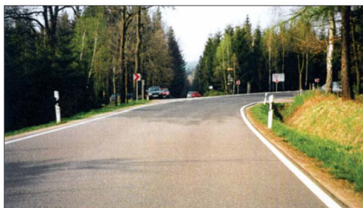
Interseção em curva (antes)
