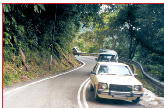
Rodovia inadequada para boa mobilidade e volumes de tráfego elevados
